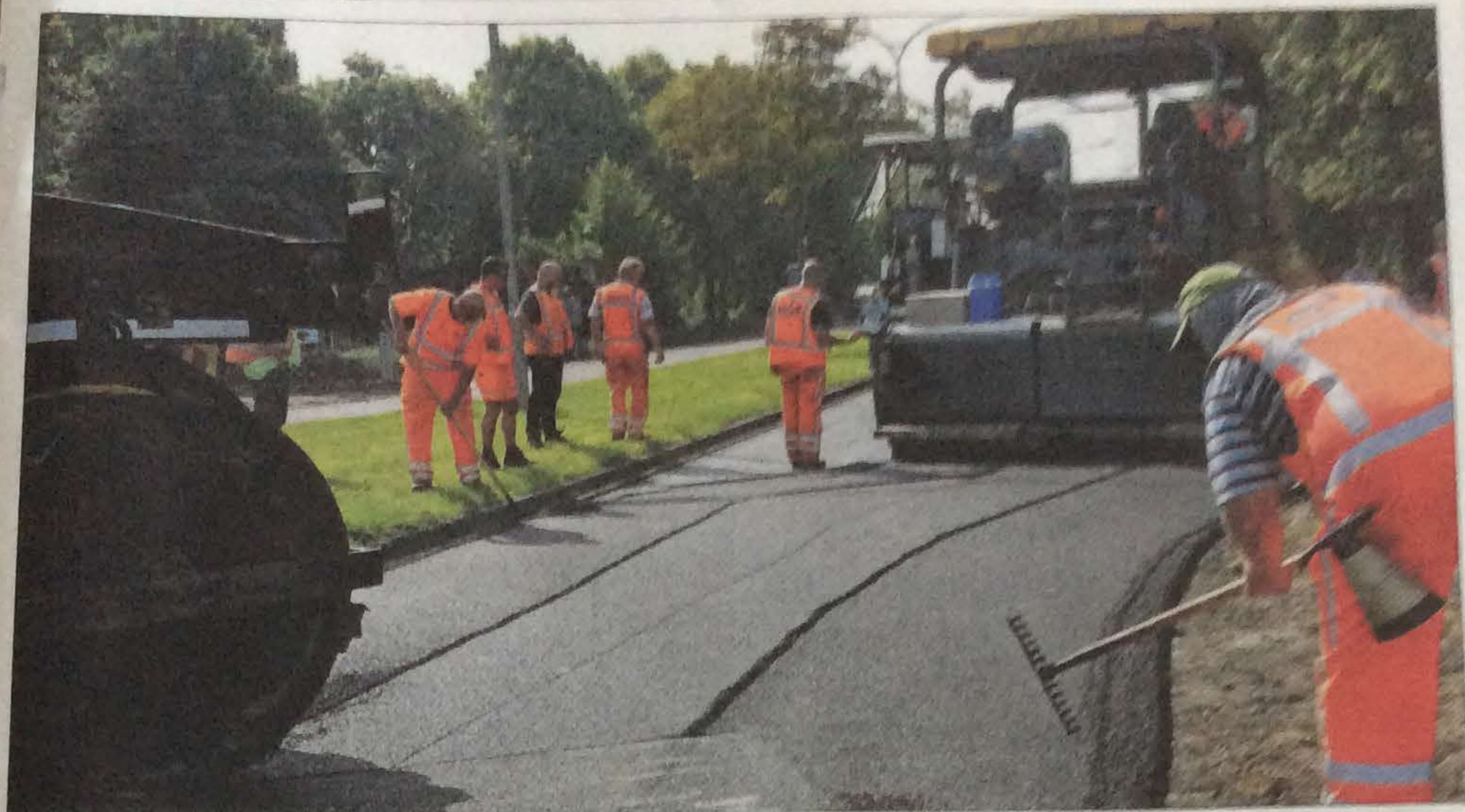
■ Asfalteren van de Rooseveltlaan in Terneuzen met asfalt waarin rubber van vrachtautobanden is verwerkt. Sinds maandag is de weg open. foto Peter Nicolai
